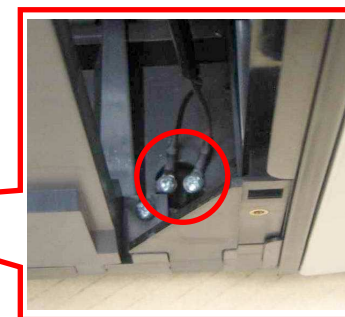
Sensor auf Bodenplatte
